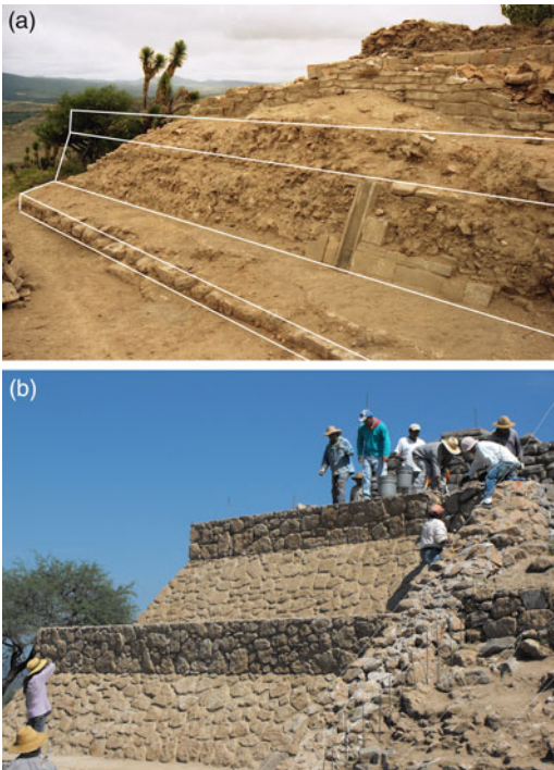
Figura 4. Segunda etapa del Edificio Principal: (a) fachada norte; (b) reconstrucción en la fachada sur. (Color en la versión electrónica)
